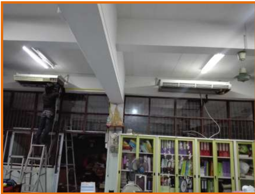
ภาพที่ ๒ ติดตั้งเครื่องปรับอากาศ
